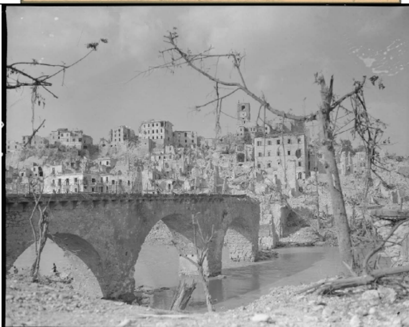
Référence : Terre 226-5090 Le village de Pontecorvo qui vient d'être pris par la division Brosset [la 1 re division de marche d'infanterie]. Au premier plan, le pont sur le Liri qui a été détruit par les Allemands pendant leur retraite. Photographe SCA inconnu, copyright ECPAD
